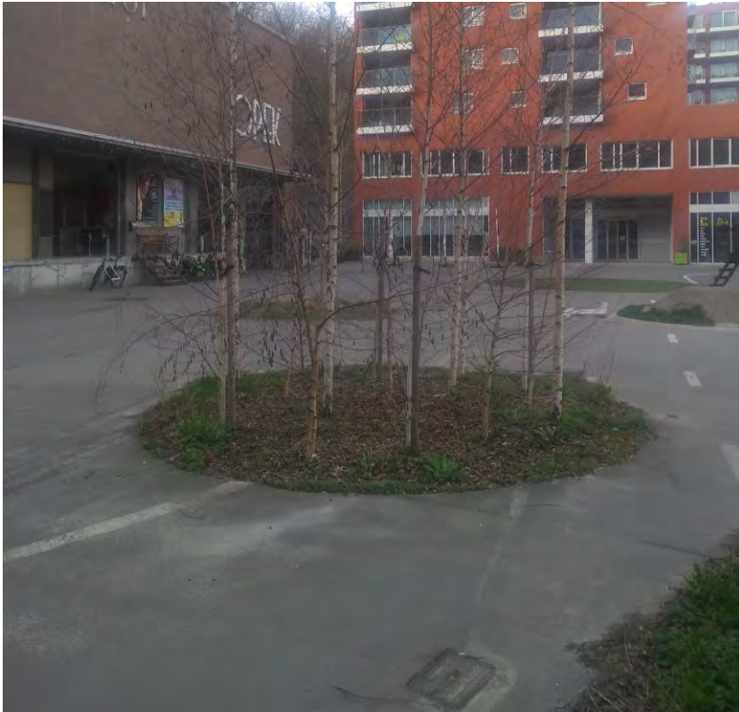
Gedeeltelijke ontharding van bestaande terreinen (perforatie)
