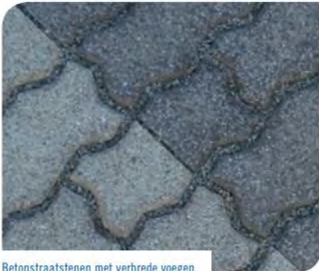
Betonstraatstenen met verbrede voegen
