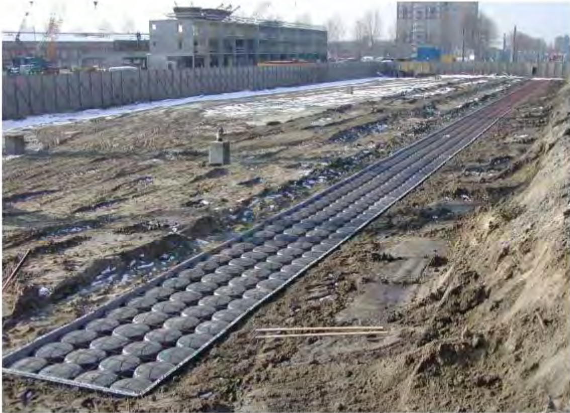
Aanleg van ondergrondse buffervoorziening – Waterblock BV
