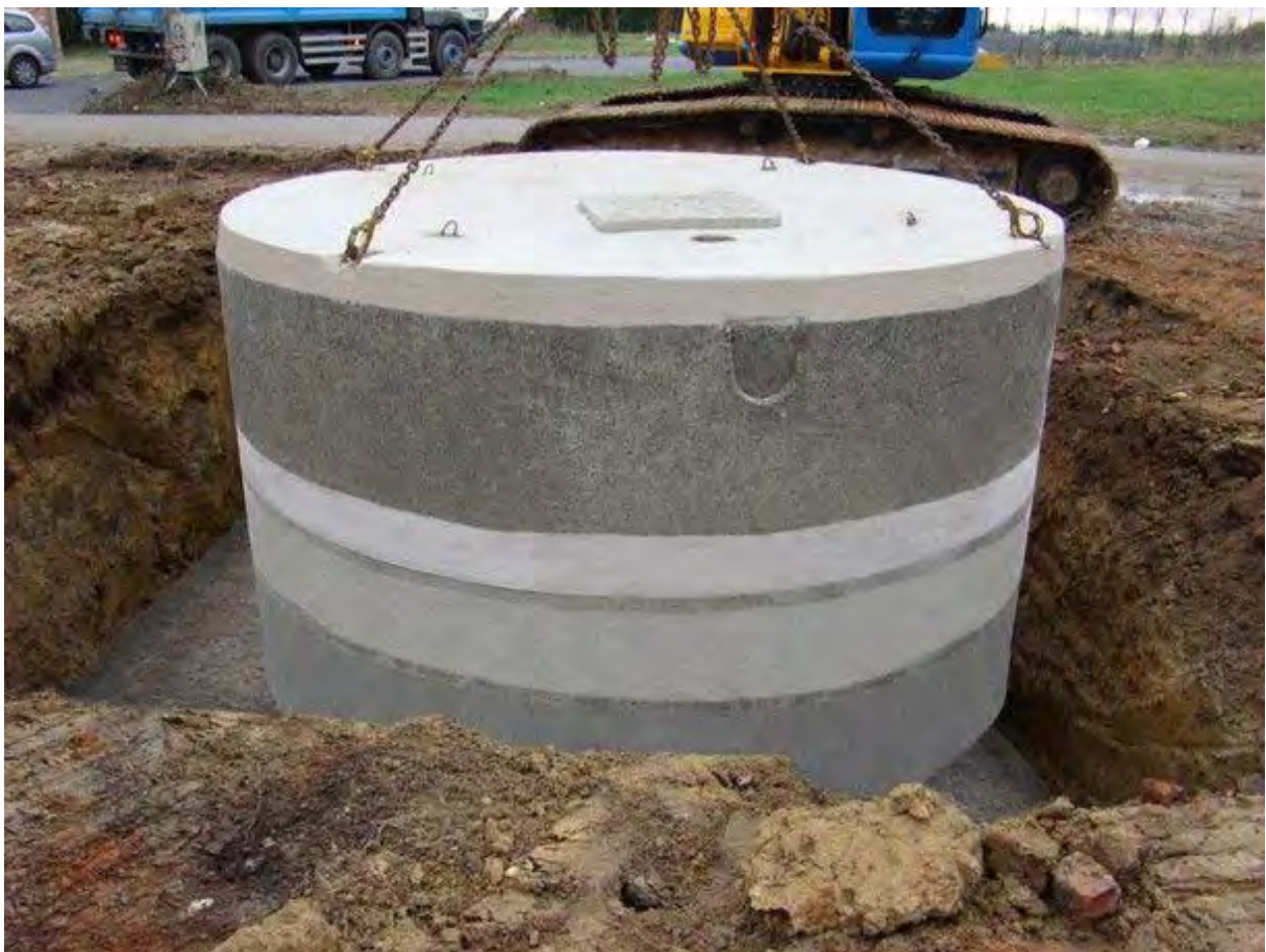
Combinatie hemelwaterput (onderste deel) en infiltratievoorziening (bovenste deel)
