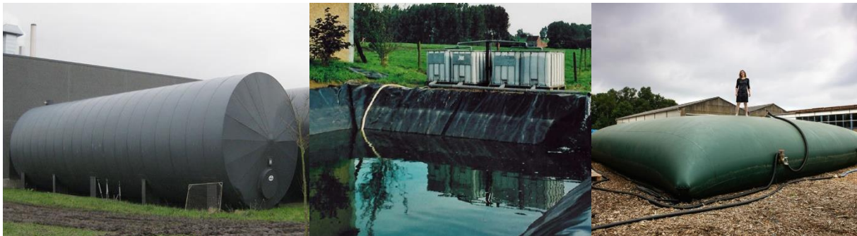
Figuur 47. Buffertanks, een foliebekken en een zak, voor de opslag van regenwater (Bron: Departement Landbouw en Visserij; Provincie Oost-Vlaanderen; De Standaard).
