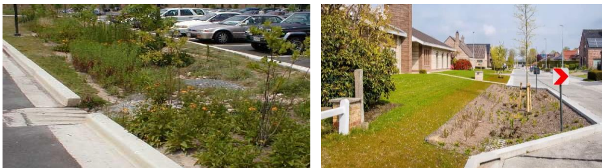
Figuur 33: Voorbeelden van gat in boordsteen (links onder) en verlaagde wegversmalling (rechts onder). Bron: Aquafin
