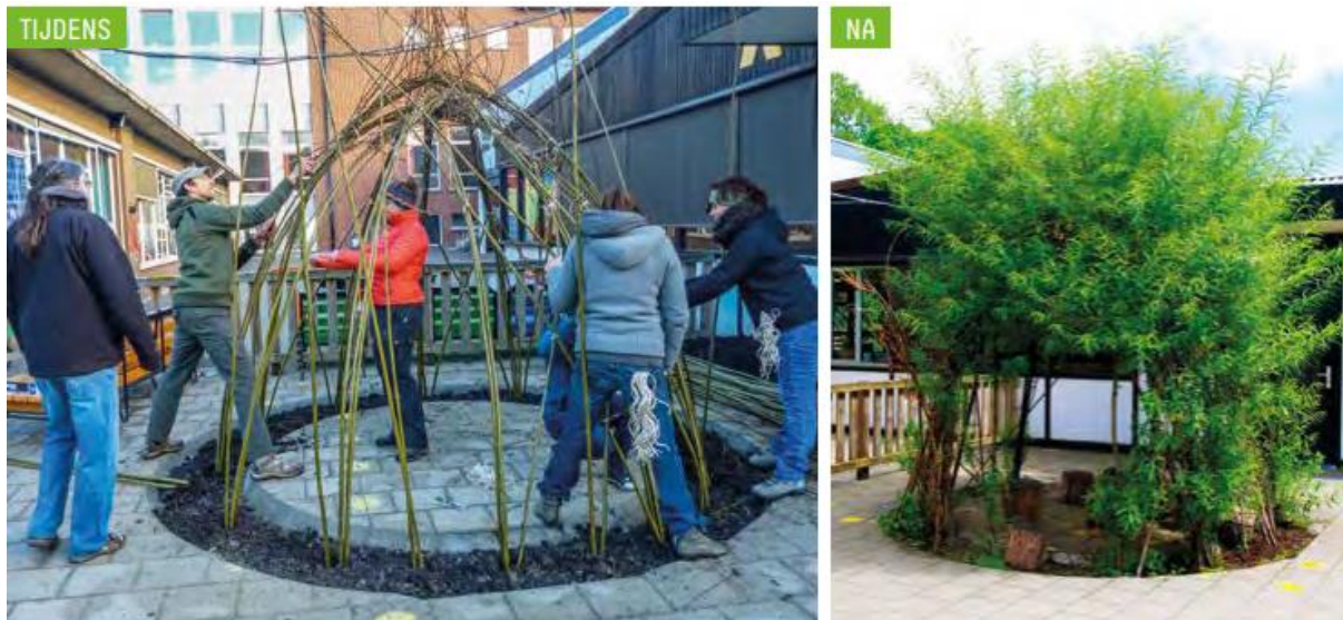
Figuur 44: De bouw van een wilgenhut op de Vrije kleuterschool Mater Dei in Leuven (bron: inspiratiegids voor groene speelplaatsen van de provincie Vlaams-Brabant)
